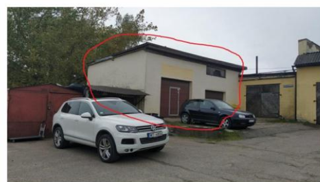
FOTO 2 Autoremontdarbnīcai (kad.apz.8070 008 0638 004) piebūvētā būve
