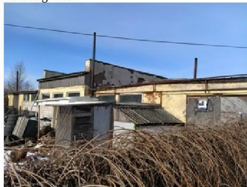
Autoremontu darbnīcai uzbūvēta piebūve.
