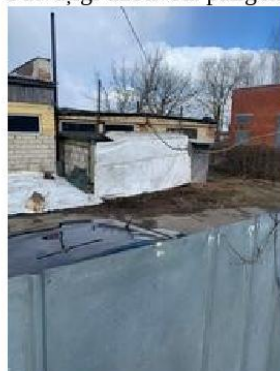
Autoremontu darbnīcai uzbūvēta piebūve.
