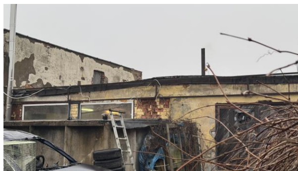
Vērtējamā būve ar piebūvi.
