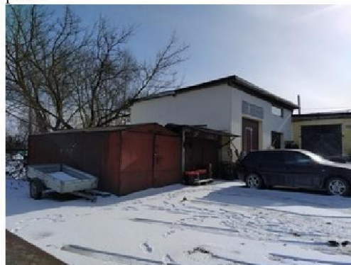
Autoremontu darbnīcai piebūvēta būve kreisajā pusē, patvaļīgi uzcelta garāža un novietota metāla garāža.
