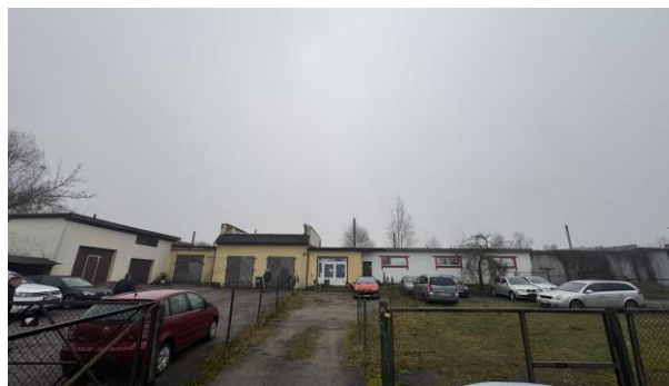
Skats uz vērtējamo objektu un patvaļīgi veiktajām piebūvēm un būvēm.
